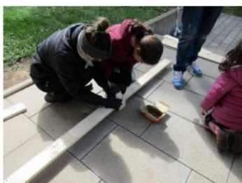
Bau eines Hochbeets für den Stadtteiltreff NaSe
